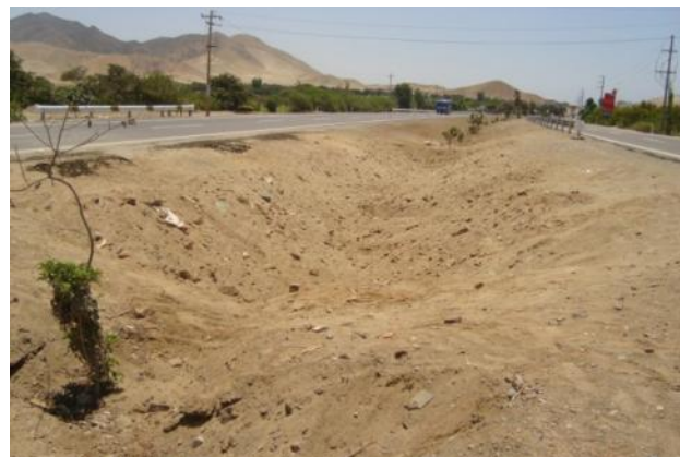
Eliminación de pases vehiculares no autorizados.
