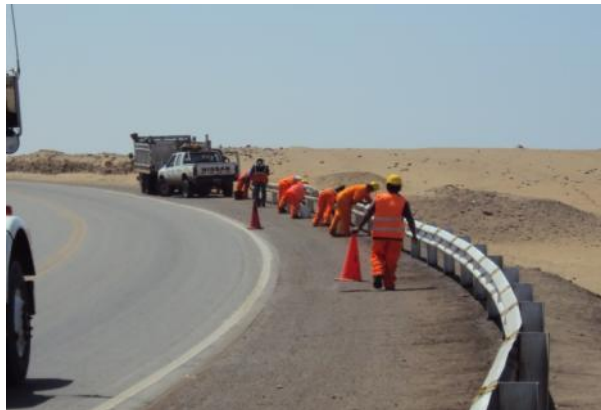
Trabajos de mantenimiento en guardavías.
