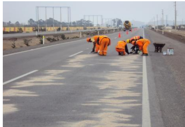
Personal realizando trabajos de tratamiento de fisuras.
