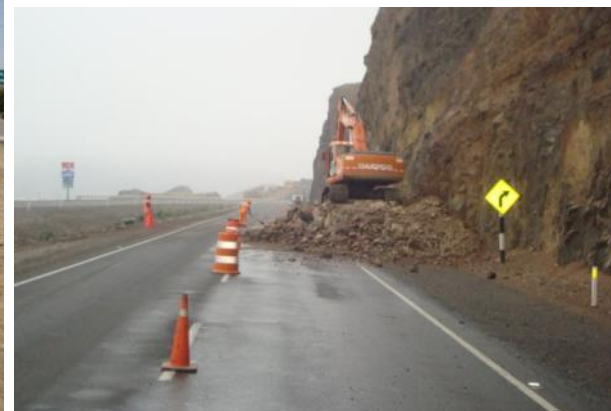
Trabajos de limpieza por derrumbes en la autopista.
