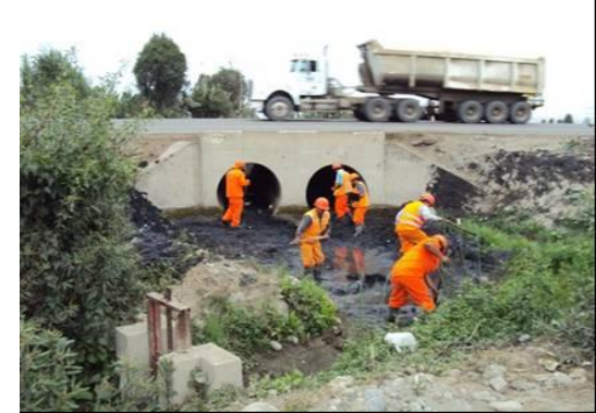
Limpieza de Alcantarilla
