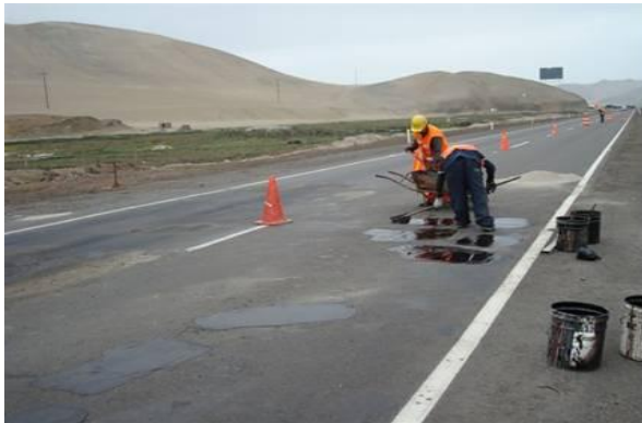
Personal realizando labores de parchado, tratamiento de fisuras
