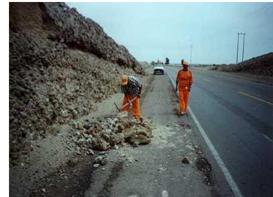
Personal realizando Limpieza de Derrumbes
