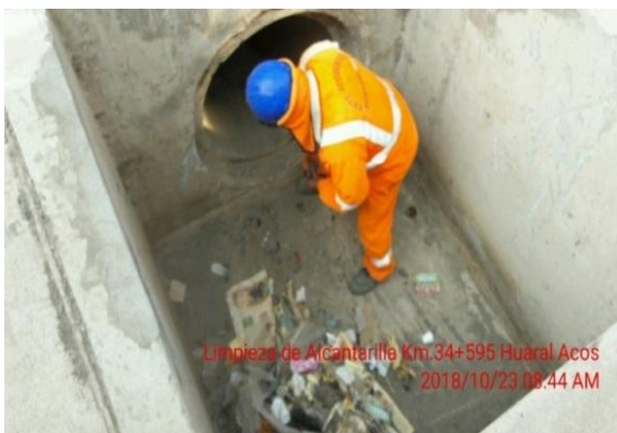
Limpeza de Alcantarillas
