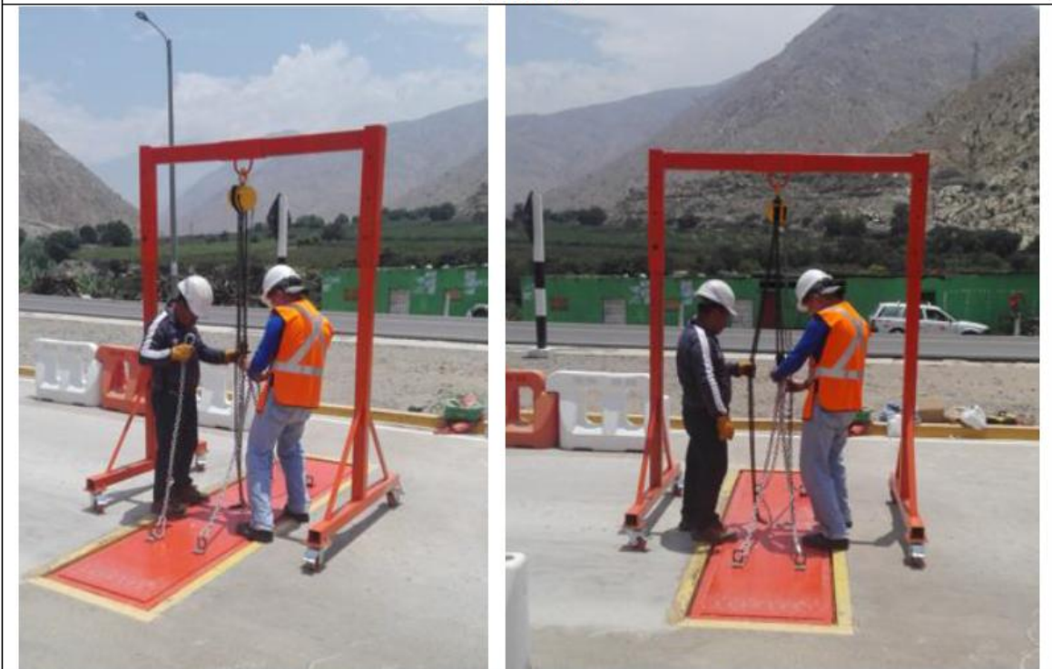
INSTALACION DE TECLE PARA PODER LEVANTAR LA PLATAFORMA DE PESAJE Y PROCEDER CON EL MANTENIMIENTO DEL EQUIPO R300
