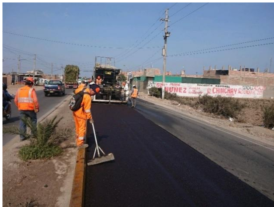
Colocación de Micropavimento
