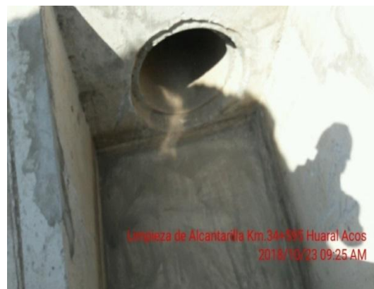
Limpeza de Alcantarillas
