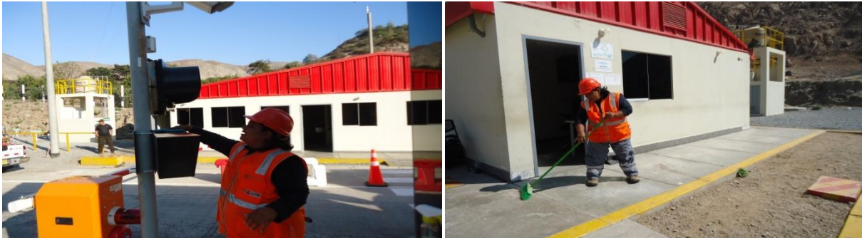
Conservación de la unidad de Peaje
