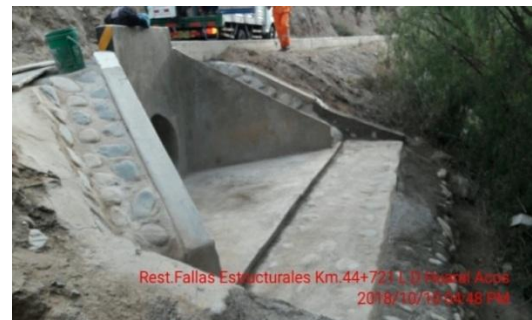
Reparaciones menores en Alcantarillas
