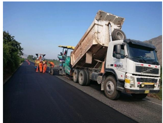
Colocación de Carpeta Asfáltica
