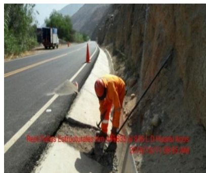
Reparación menor de cuneta revestida
