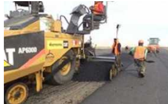
Mantenimiento a la pista de aterrizaje
