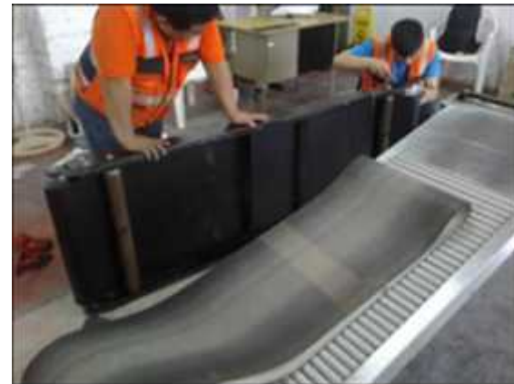
Mantenimiento al sistema de manejo de equipajes (Faja)
