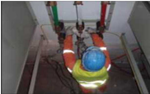
Mantenimiento al sistema eléctrico
