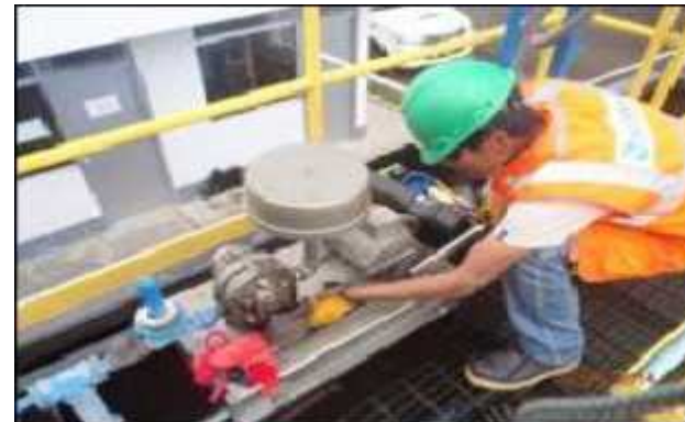
Mantenimiento a la Planta de Tratamiento de Aguas Residuales (PTAR)
