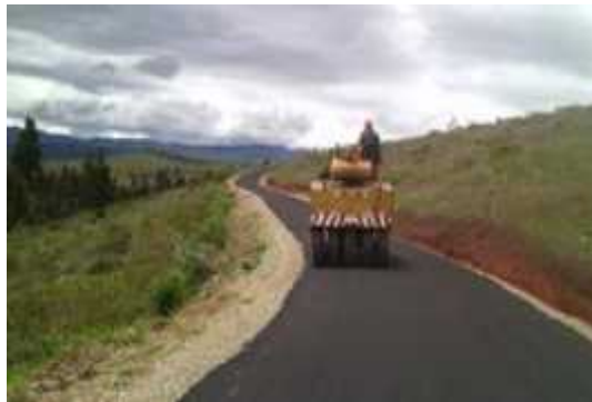
Mantenimiento a la vía perimetral
