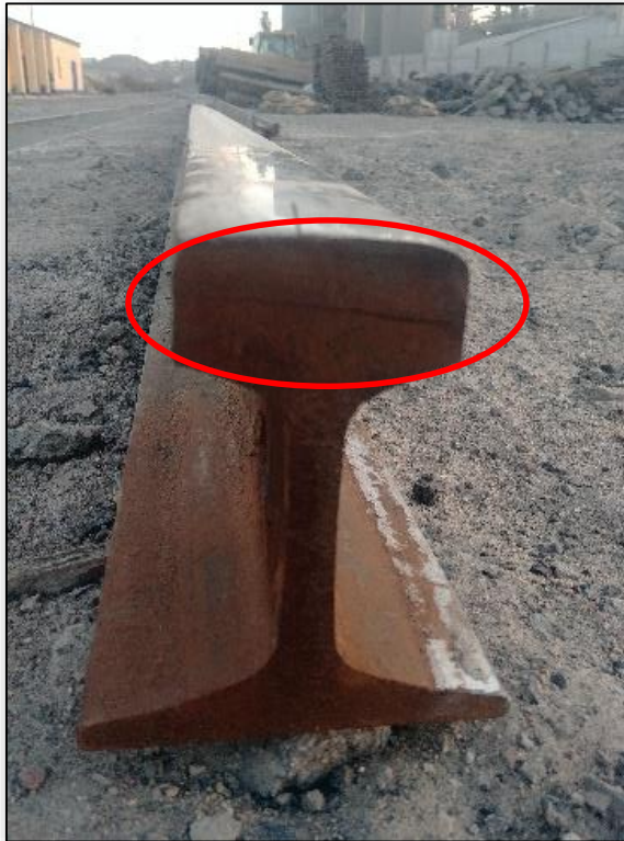
PK 24+447 (SUBD04): Horizontal Split Head (Fisura Horizontal en Cabeza de Riel)
