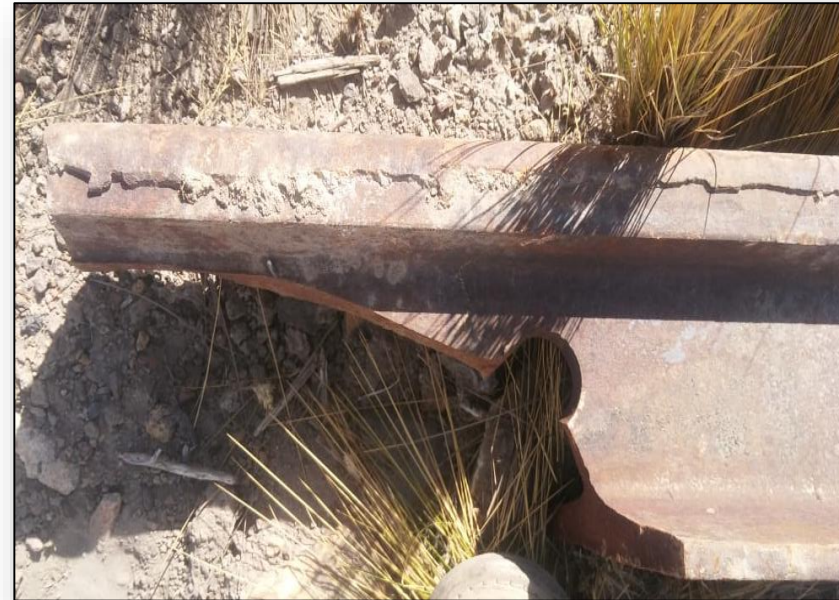
PK 136+360 (SUBD04): Bolt Hole Cracked (Rotura en el Agujero de Perno)
