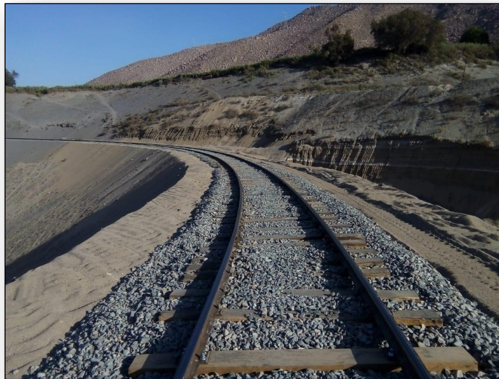
Reforzamiento de Terraplén en km 161.100 SD3
