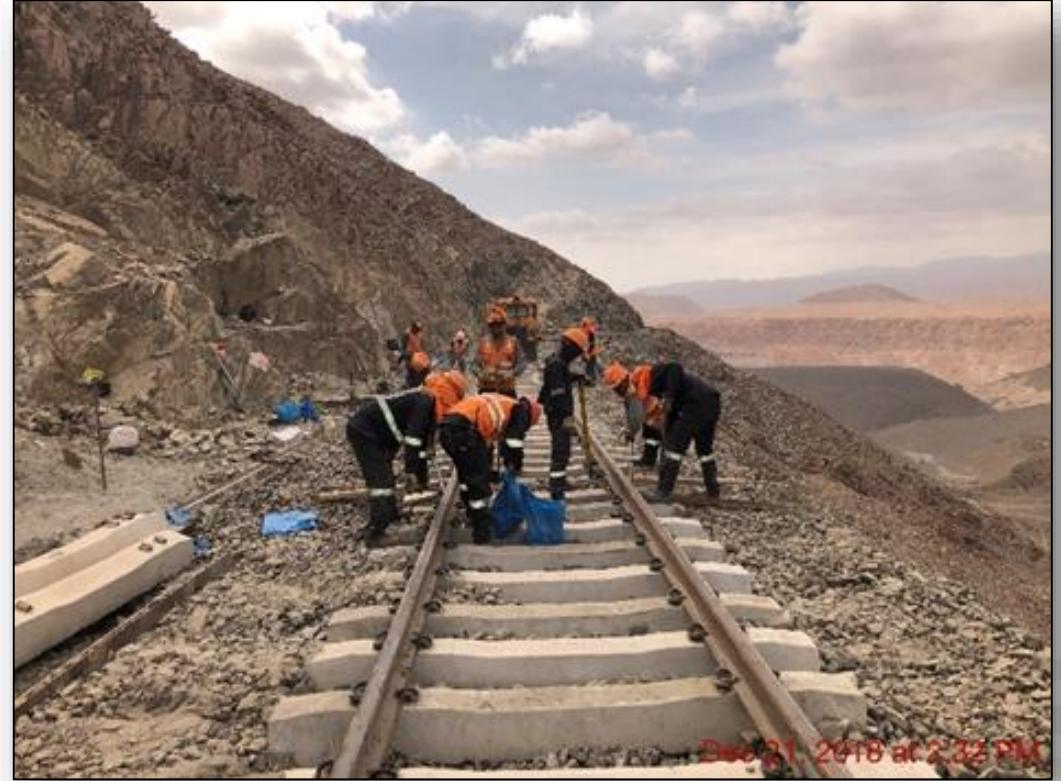
Cambio superestructura km 135.600 SD3
