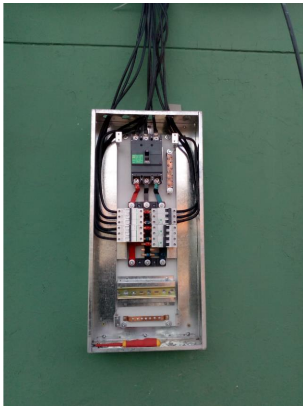
Rehabilitación de Tablero Eléctrico General
