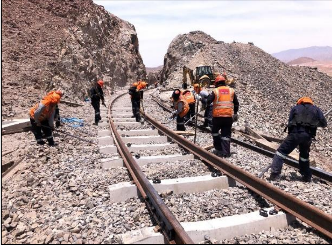
Cambio superestructura km 135.600 SD3
