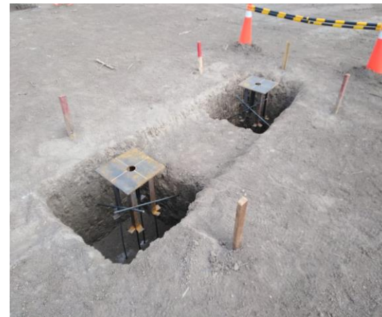
Cimentación de planta de concreto
