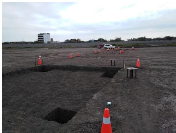
Cimentación de planta de concreto
