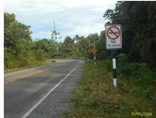
Limpieza de Placas de Señalización
