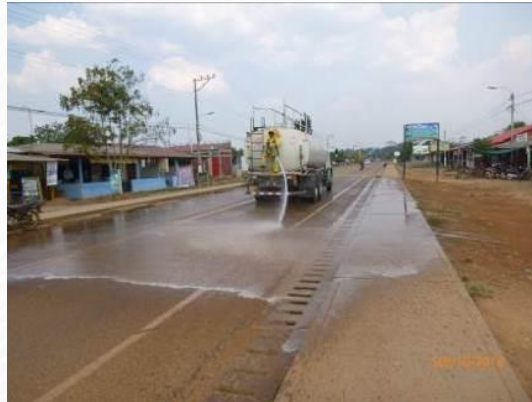
Limpieza de calzada y berma
