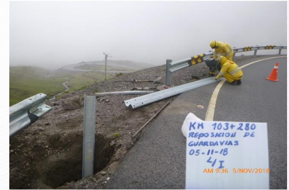
Reposición de guardavías
