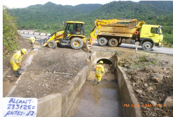
Limpieza de alcantarillas
