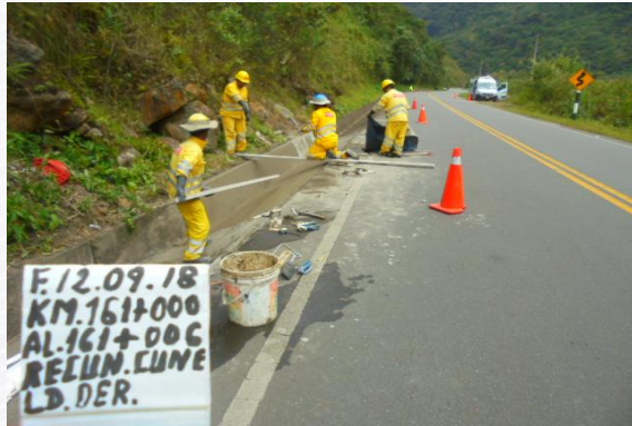
Reparación de cuneta de vía
