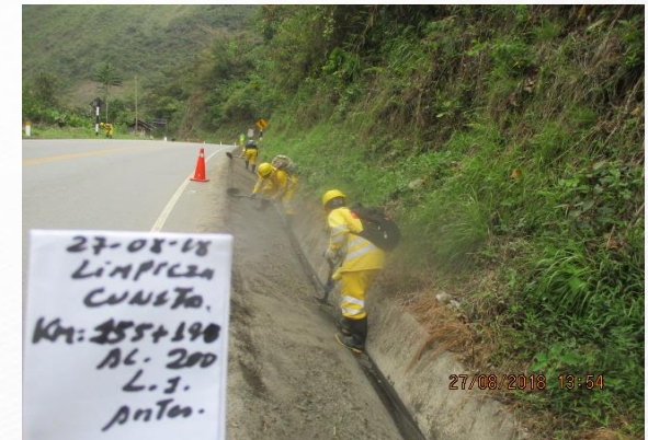
Limpieza de cuneta de vía
