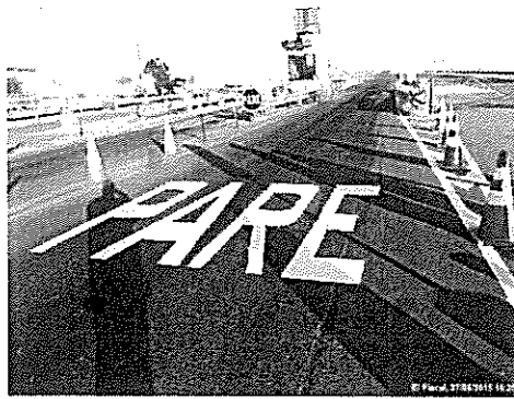
Vistas N° 01 y 02: Pintado de marcas en el pavimento de Peajes
