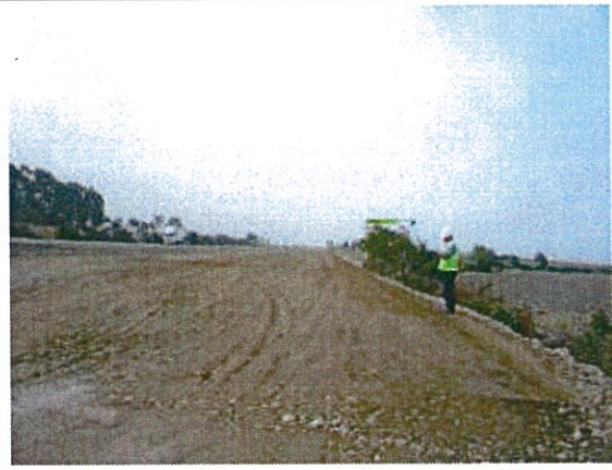
KM. 197+470 Sector en ejecución, final de conformación de plataforma con relleno compactado 3ra capa de 30 cm. c/u. Vista N-S
