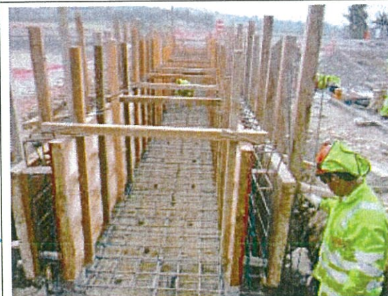
KM. 197+012 Alcantarilla tipo marco de C°A° de 1.00 m X 1.00 m en ejecución, solado y encofrado y de armadura de refuerzo de la losa inferior y muros. Vista O-E
