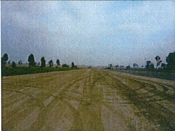
KM. 197+470 Sector en ejecución, inicio de conformación de plataforma con relleno compactado 3ra capa de 30 cm. c/u. Vista N-S
