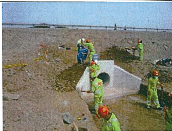
KM. 159+519 Alcantarilla tipo TMC de 36" en ejecución, colocación de tubería y cabezal terminado. Relleno estructural en proceso final. Vista E-O.
