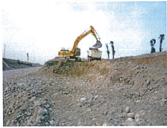
KM. 198+440 Sector en ejecución, actividades de corte de material suelto y eliminación de material suelto. Vista N-S
