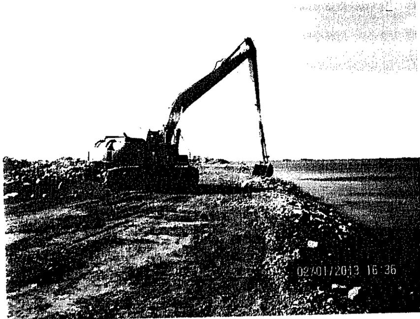
Fotografía 4- 15: Actividad de protección de taludes en tramo 0+095 - 0+125.
