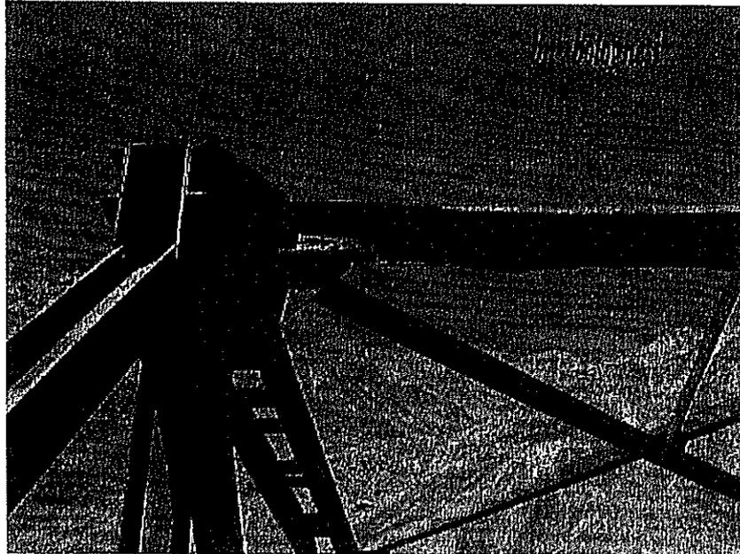
Arcos metálicos del puente corroídos y rotos
